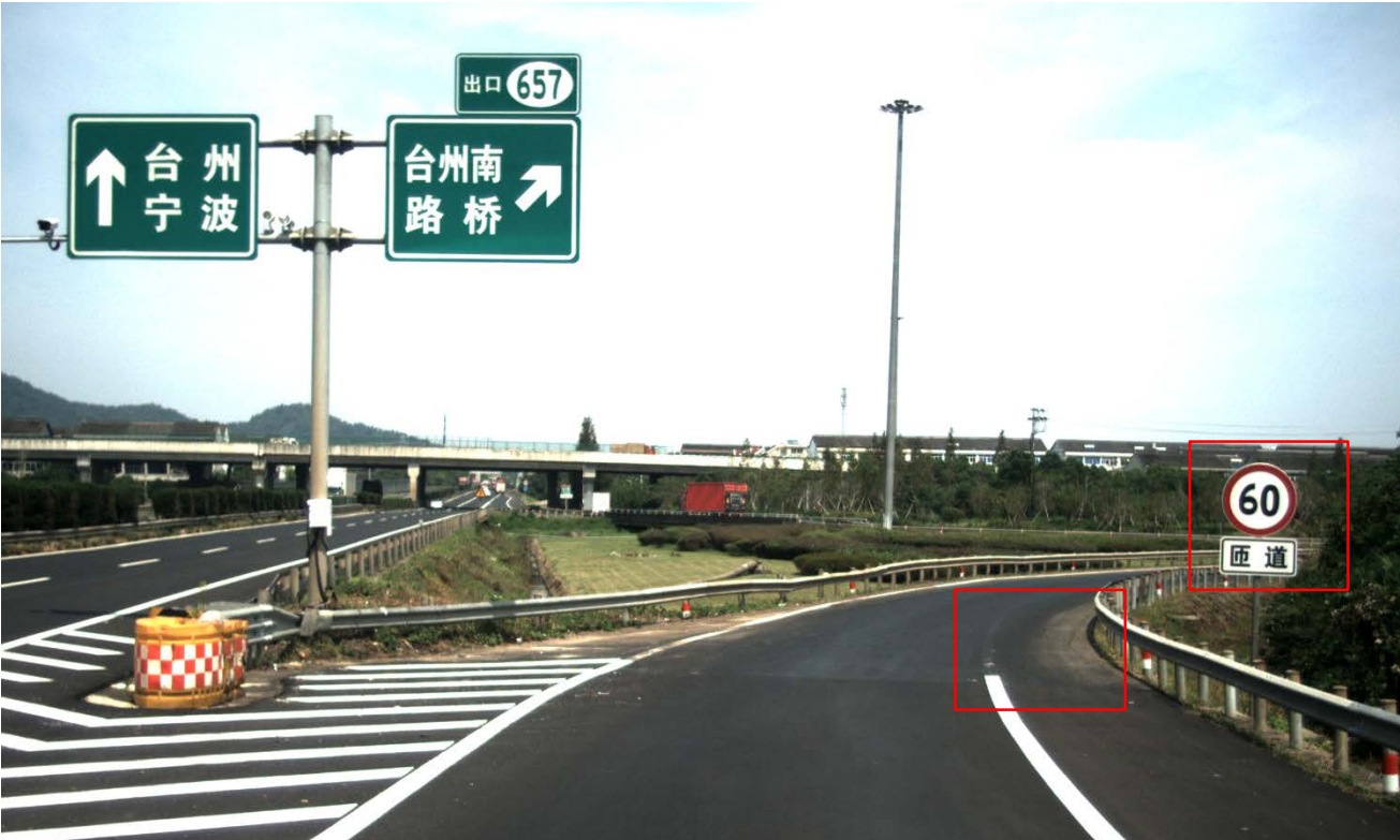
图 20 A 匝道存在的问题：1.限速标志滞后，2.缺少线形诱导标志，3.进入匝道后无相应限速标志，4.标线磨损严重
