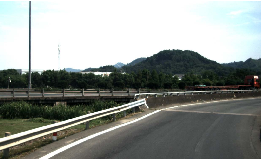
图 21 未设置桥路连接处过渡搭接
