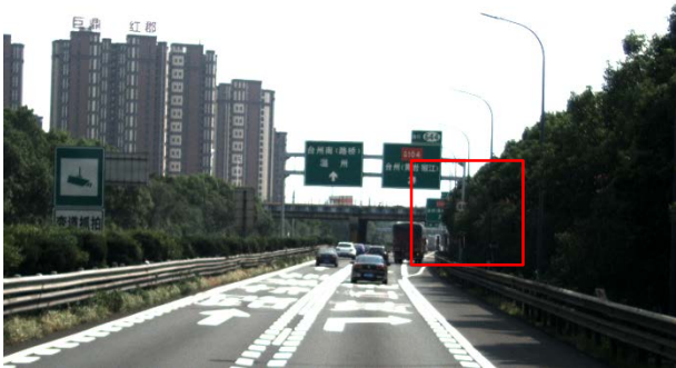
图 11 主线匝道限速 80 标志被遮挡
