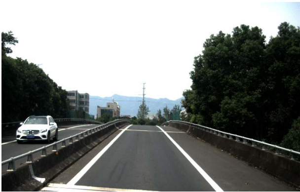
图 13 视线不良路段：上坡连接陡下坡弯道
