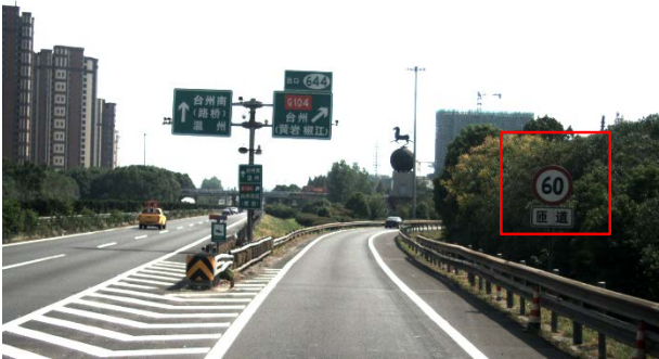
图 12 匝道限速 60 靠后，缺少匝道 30 限速标志
