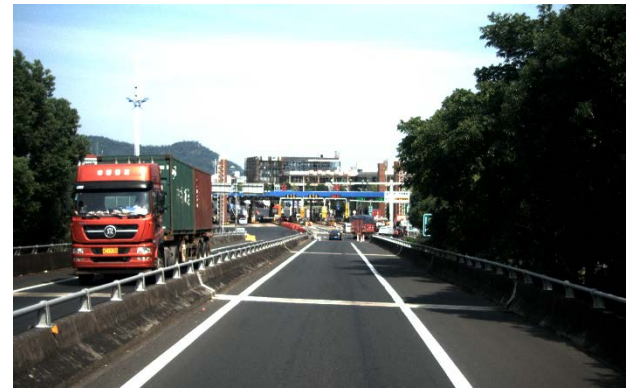
图 14 A 匝道与 D 匝道合流缺少注意合流标志
