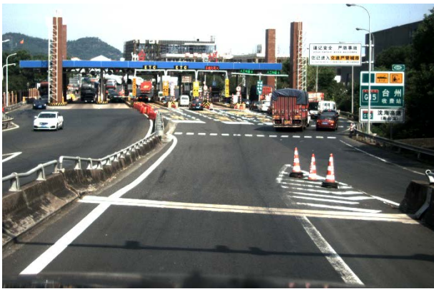
图 15 A 匝道高速分合流端头标线磨损
