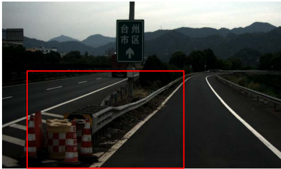
图 7 现状主线匝道分流端可导向防撞垫
