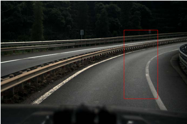
图 5 现状 F 匝道标线磨损
